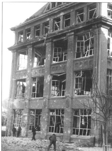
Рис. 2.35. Производственный корпус завода «Гроц-Беккерт» (июнь 1945 г.)
