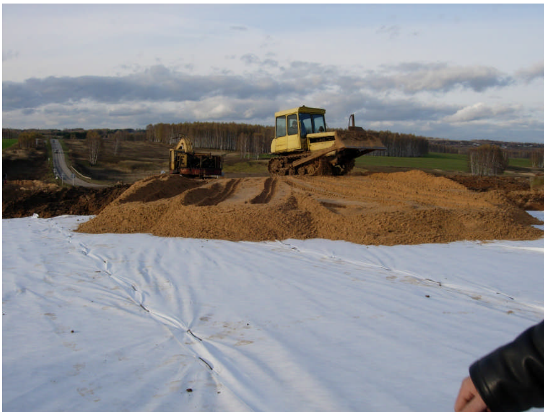
Рис. 3.1. Противокарстовые мероприятия (укладка геополотна)
