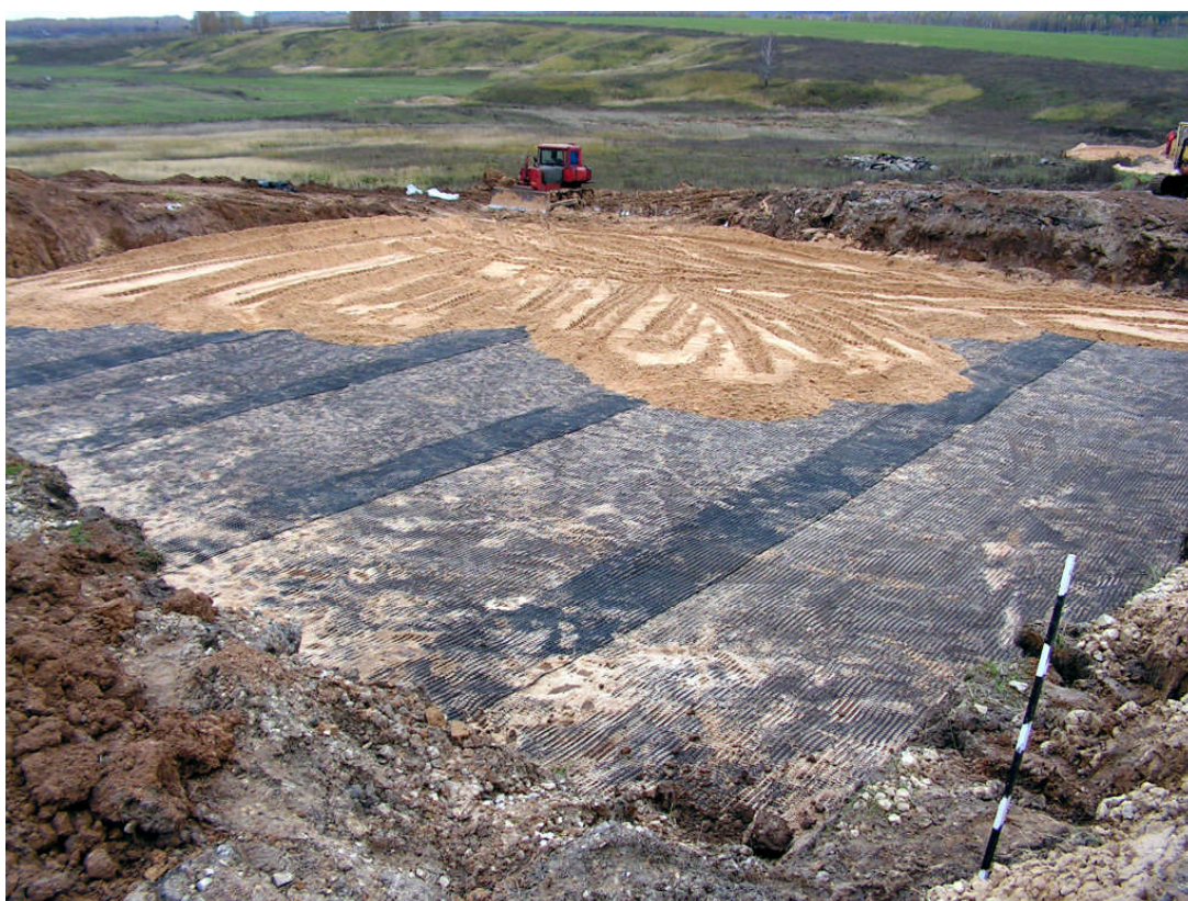
Рис. 3.2. Противокарстовые мероприятия (укладка георешетки)
