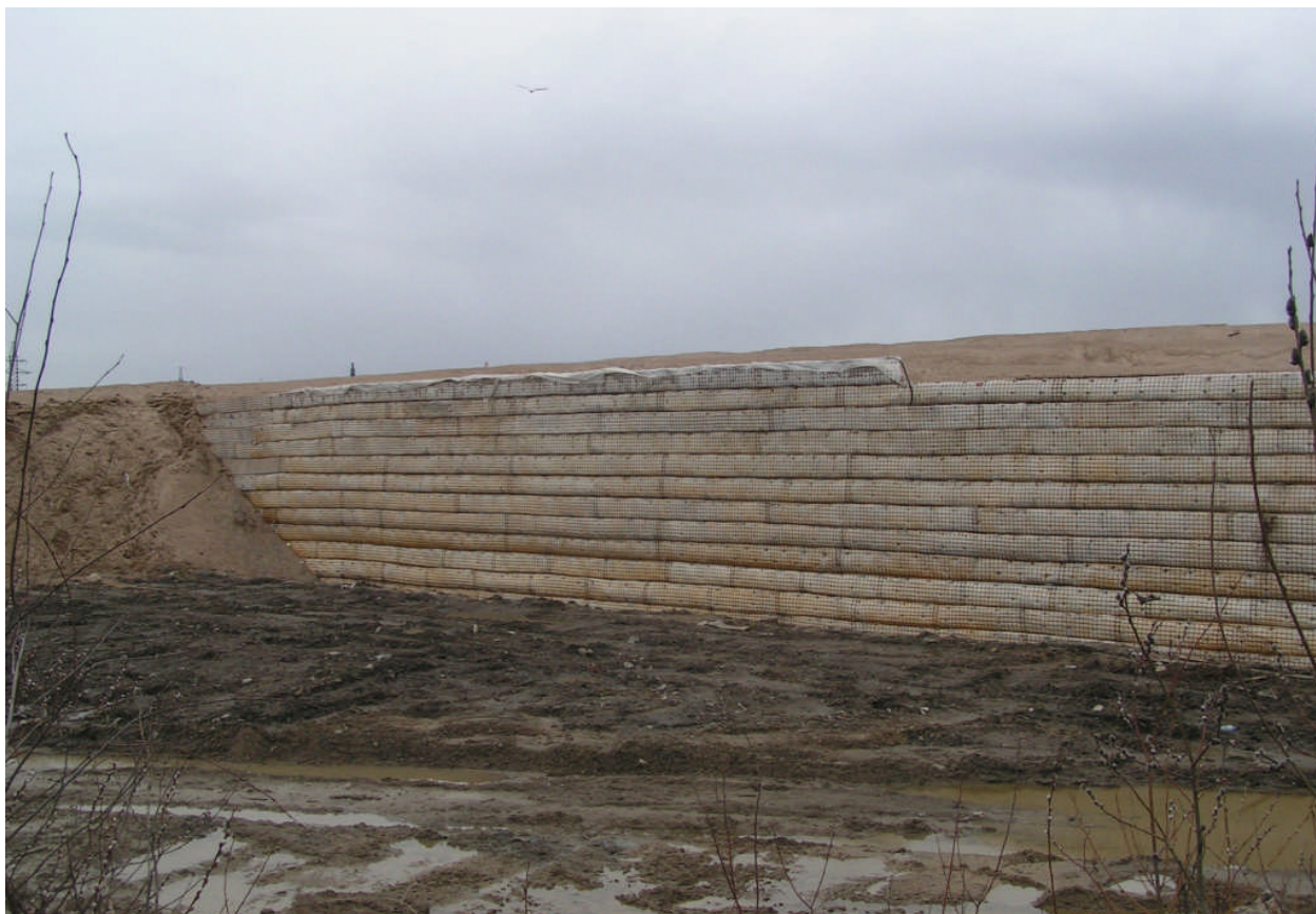
Рис. 3.3. Армогрунтовая конструкция подпорной стенки
