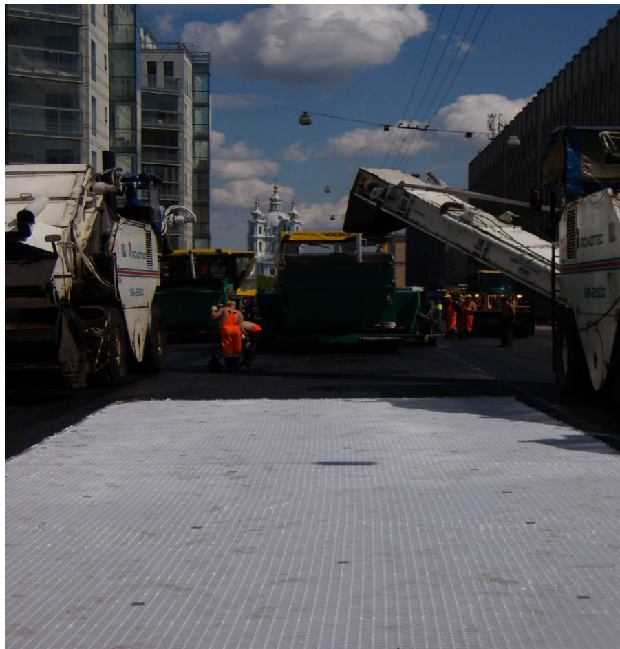
Рис. 3.5. Использование противоэрозионного мата
