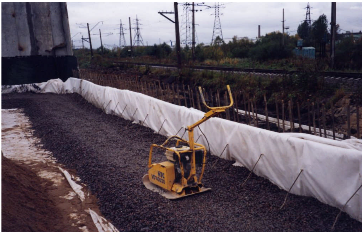
Рис. 3.4. Этап строительства армогрунтовой конструкции
