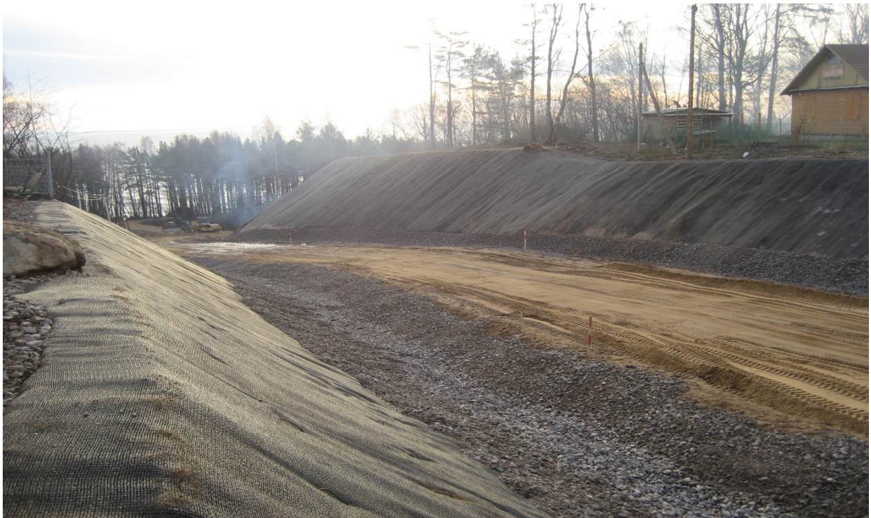
Рис. 3.5. Использование противоэрозионного мата
